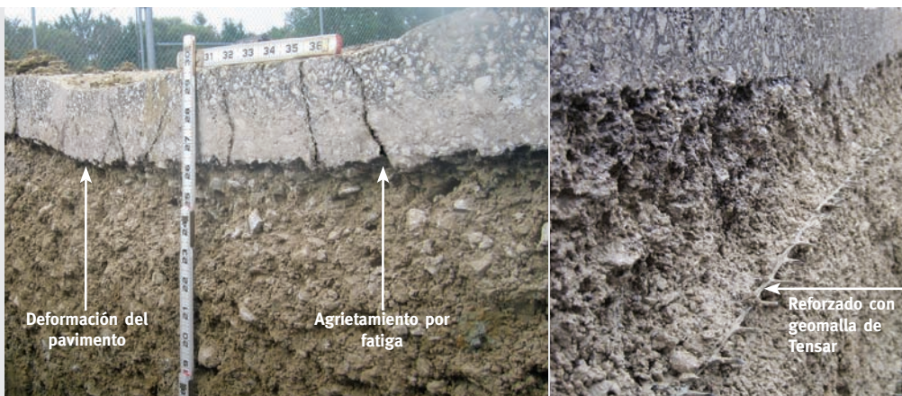
Figura 13 En el corte de la sección ya transitada de la derecha se puede ver una disminución drástica de la deformación del asfalto y el agregado gracias a la inclusión de una geomalla Tensar® en comparación con la sección no reforzada que muestra la imagen de la izquierda.
